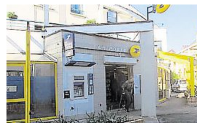
À compter du 10 mai, en raison de travaux, La Poste va fermer pour huit semaines.
